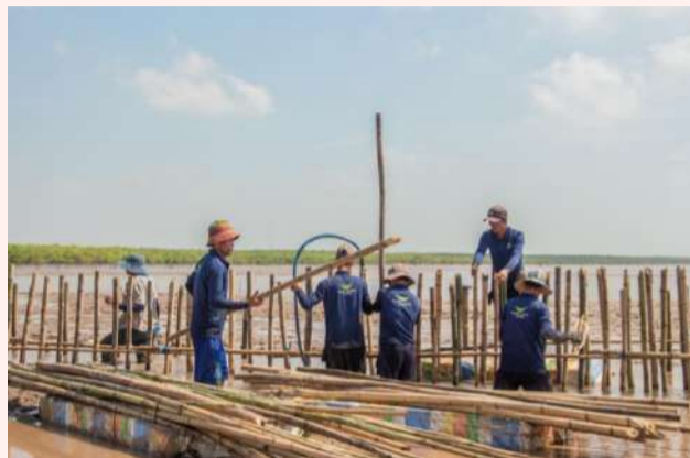
Nhân công địa phương tham gia xây dựng tường rào
