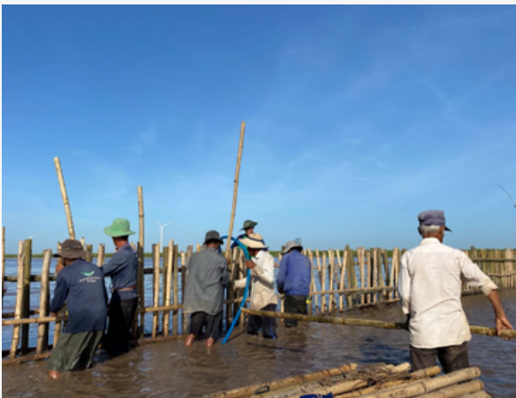
Nhân công đang sửa hàng rào, 12/2023
