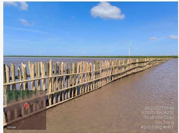
Hàng rào được gia cố hoàn thiện, 12/2023
