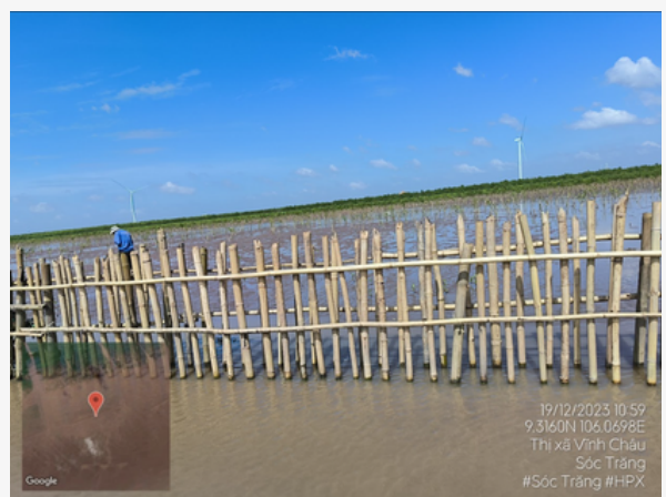
Hàng rào được gia cố hoàn thiện, 12/2023
