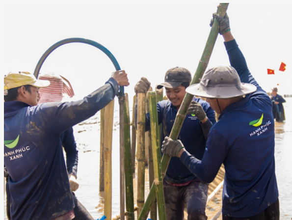
Thi công tường mềm Lô 3, 2/2023
